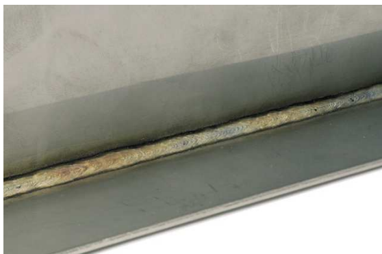
Soldadura Inox en Angulo Recto
